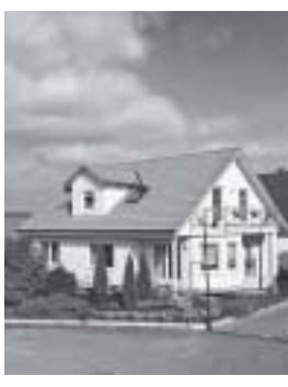
Der Blitzschlag sprengte den Kamin und setzte den Dachstuhl in Brand. Heute erstrahlt das Haus in neuem Glanz.
